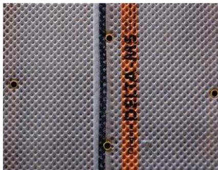
Крепежный элемент Delta Qwik-Seal, установленный в гидроизоляционную мембрану
